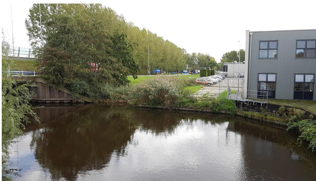
Figuur 3.2 Het noordoostelijke punt waar de fietsbrug komt te liggen.
